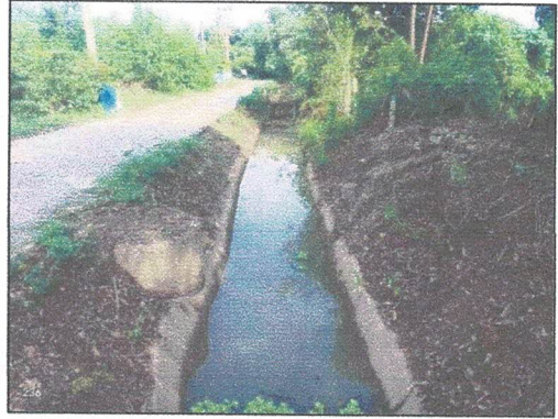
ขุดลอกตะกอนดินคูระบายน้ำ หมู่ที่ 4
