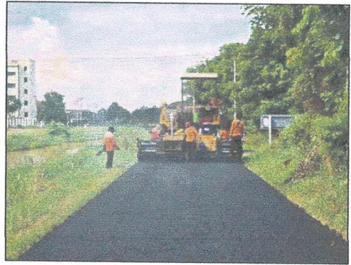
เสริมผิวลาดยางแอสฟัลท์คอนกรีตบนผิว คสล.ถนนเลียบคลองชลประทานชัยนาท-อยุธยา(ฝั่งซ้าย) หมู่ 4
